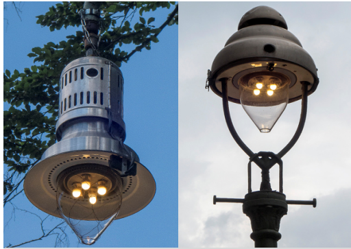
Gaslaternen mit demontierten Schaltgeräten, erkennbar am kreisrunden Loch in der Haube,
